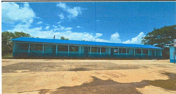
finalizacion de pintada de exterior
