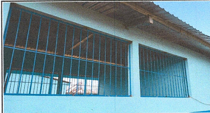
finalizacion e instalacion de Balcones en todas las aulas.
